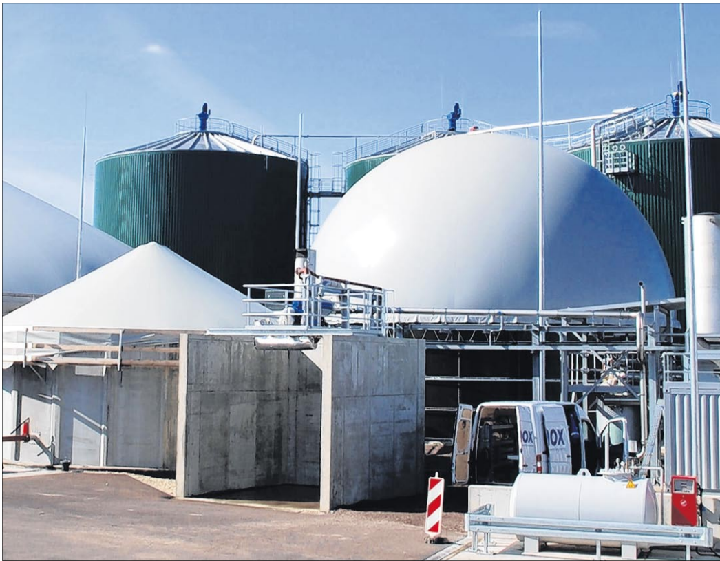
Seit dem vergangenen August produziert die 6,5-Megawatt-Biogasanlage am Ortsrand von Güterglück Biogas in Erdgasqualität. Foto: Daniela Apel
